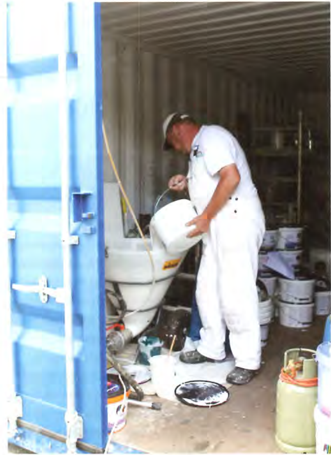
▶ Een airless pomp, met een voorraadtrechter voor 100 liter, in een container voedt de roller waarmee het sierpleisterwerk wordt gecoat.
