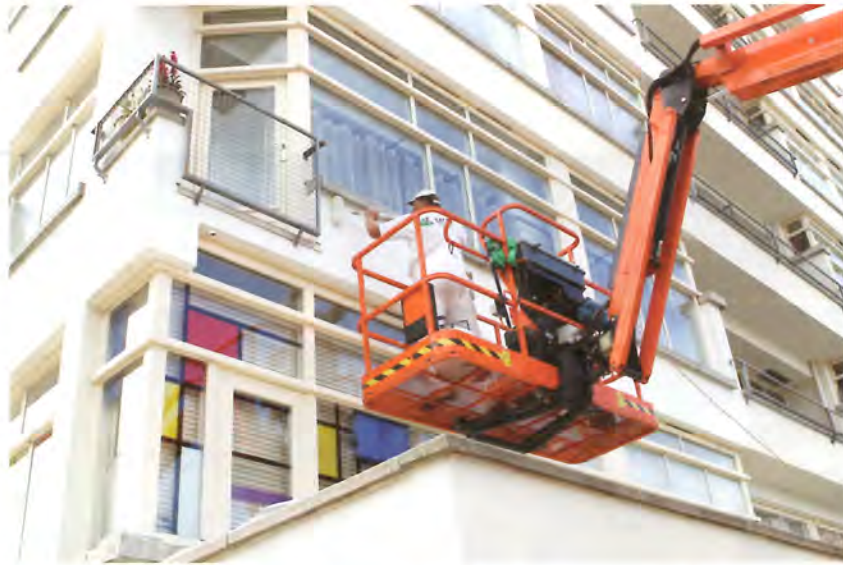
▶ Een airless pomp, met een voorraadtrechter voor 100 liter, in een container voedt de roller waarmee het sierpleisterwerk wordt gecoat.
